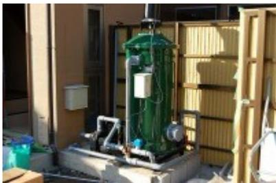
据付する場所は、水平な場所を選び、コンクリートベース等の上に据付けて水平を保ち設置して下さい。
